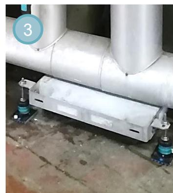
Fijación mecánica segura entre las unidades BA, generando en toda la bancada modular una carga distribuida uniforme..
