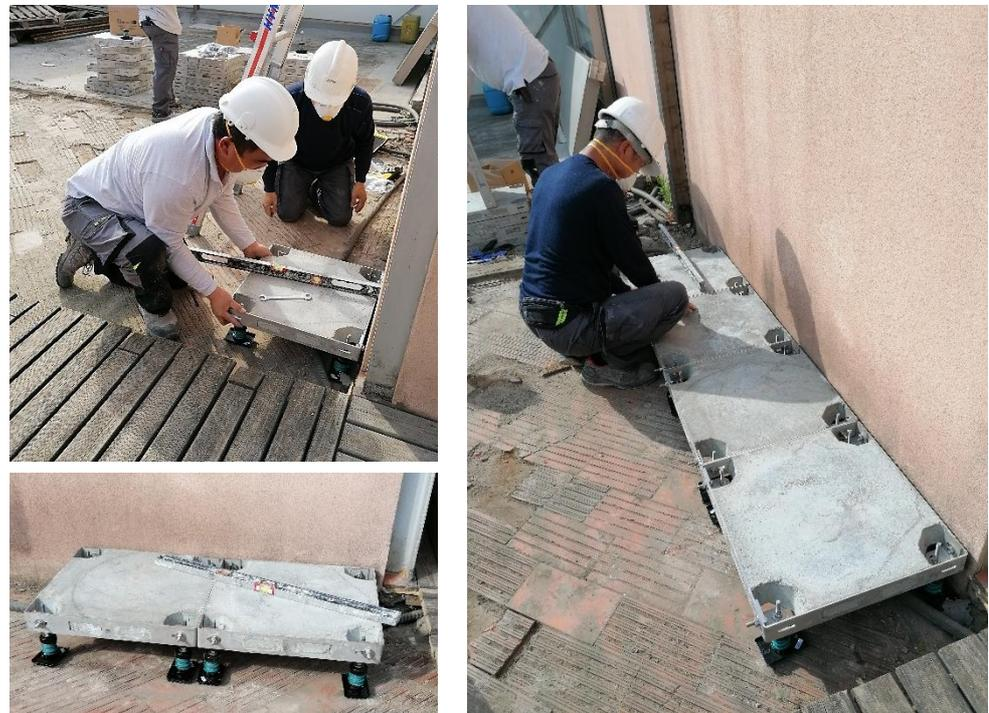
Dos operarios tardan en montar una bancada de 9 m<sup>2</sup> en 3 horas
