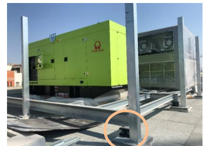
Ensayo de resistencia a la flexión de la fijación de los armazones
